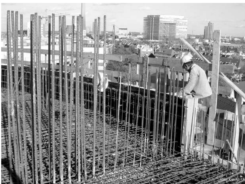
Betonstahlkonstruktion am Media-Tower in Düsseldorf
