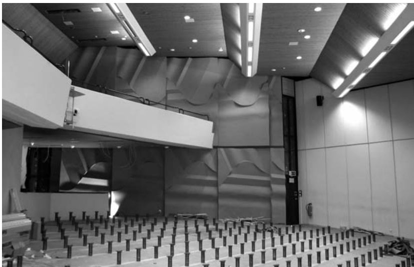
Stuhllos während der Bauphase – der Beuth-Saal
